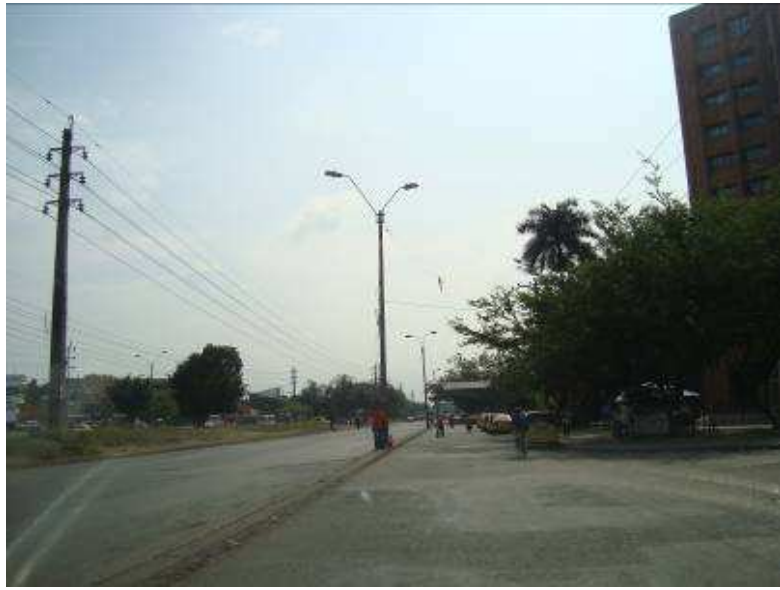
Figura 9.49. Corredor Autopista sur-oriental. Se observan las dos calzadas del costado Sur de la Autopista Sur-oriental las cuales están pavimentadas en concreto asfáltico en regular estado, sin demarcación y con señalización deficiente.
