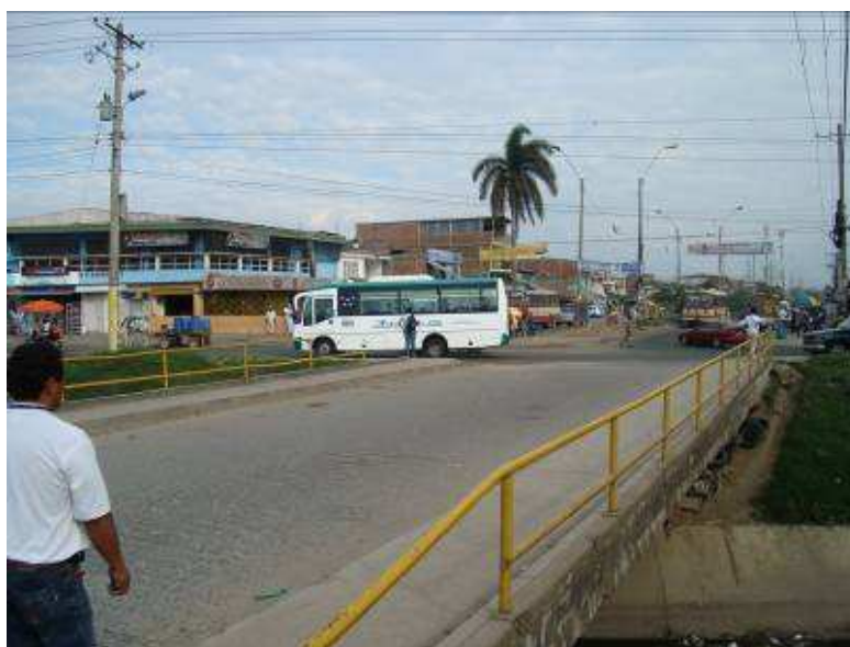
Figura 10.9. Intersección carrera 27 con calle 73. Se observan la reducción de la calzada de la carrera 27 de dos a un carril. No existe demarcación. Se observan las luminarias sobre el separador central.
