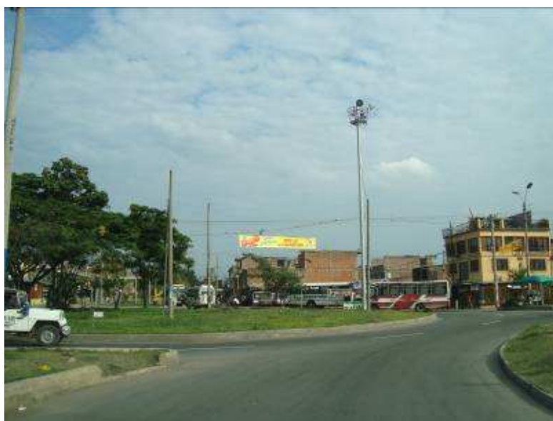
Figura 10.2. Intersección carrera 27 con calle 121, estado de la glorieta, donde inicia el recorrido de la motovía. Se observa que la demarcación y a señalización son deficientes
