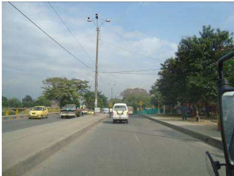
Figura 10.16. Intersección carrera 28D con calle 70, sin demarcación, se observan luminarias y andenes en buen estado. La Carrera 28D presenta dos calzadas con dos carriles al llegar a la intersección.
