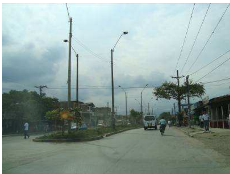
Figura 9.3. Corredor carrera 27. Se observan las características físicas que posee la vía, donde la demarcación de la calzada es nula. En el separador central se observan las luminarias existentes. En este sector, el ancho de separador es más amplio.
