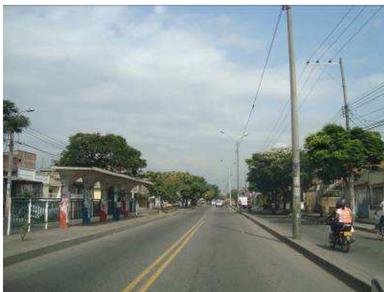
Figura 9.21. Corredor Carrera 27. Se observan las tres calzadas, siendo las laterales más estrechas, mientras que la calzada central es más amplia y posee cobertizos contruidos en concreto, y en sitios donde se han ampliado los andenes. Se observan las luminarias sobre el separador lateral y en el costado izquierdo.
