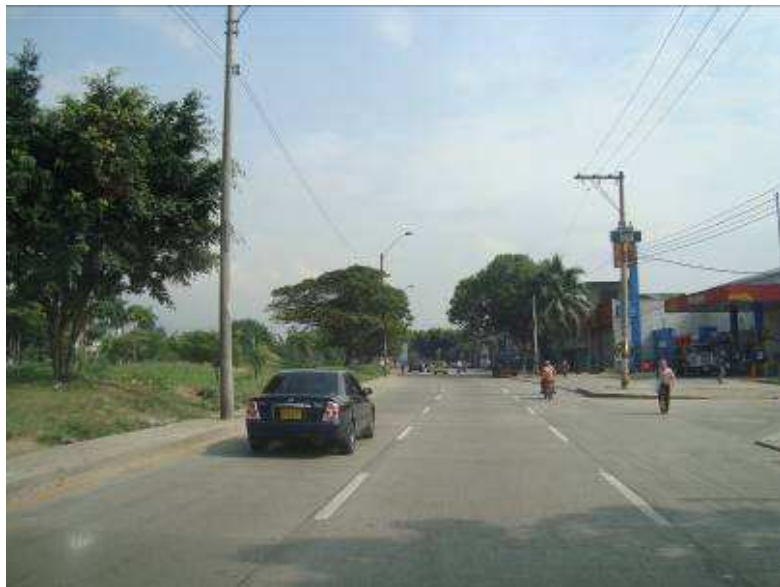
Figura 9.35 Corredor Calle 26. Este tramo presenta un pavimento rígido recién construido con demarcación de líneas de carril. Se observan las luminarias en el separador central y la existencia de andenes en ambos costados.
