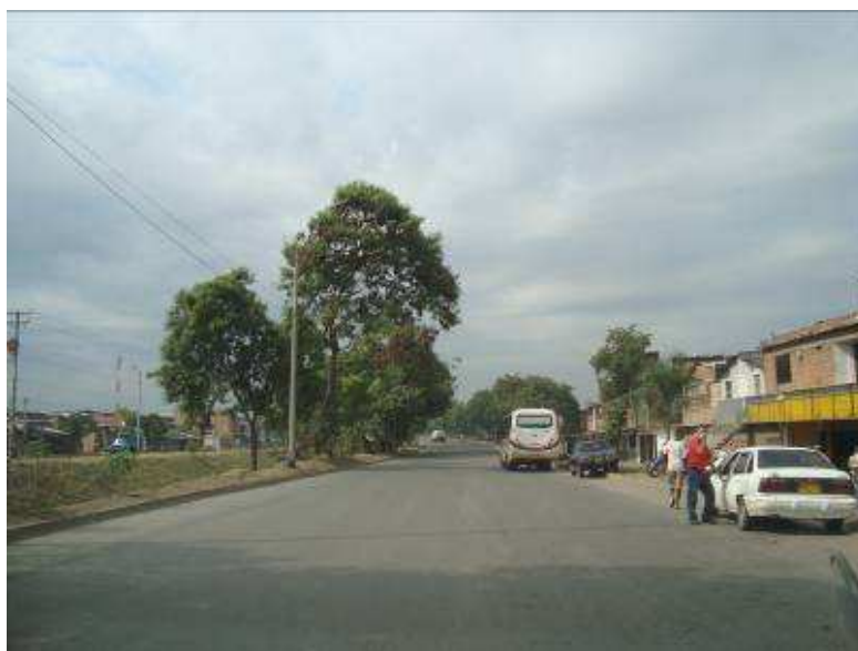
Figura 9.12. Corredor Calle 73. La vía aunque posee tres carriles, éstos no se encuentran demarcados. Se observa estacionamiento de vehículos sobre el carril derecho y en el andén.
