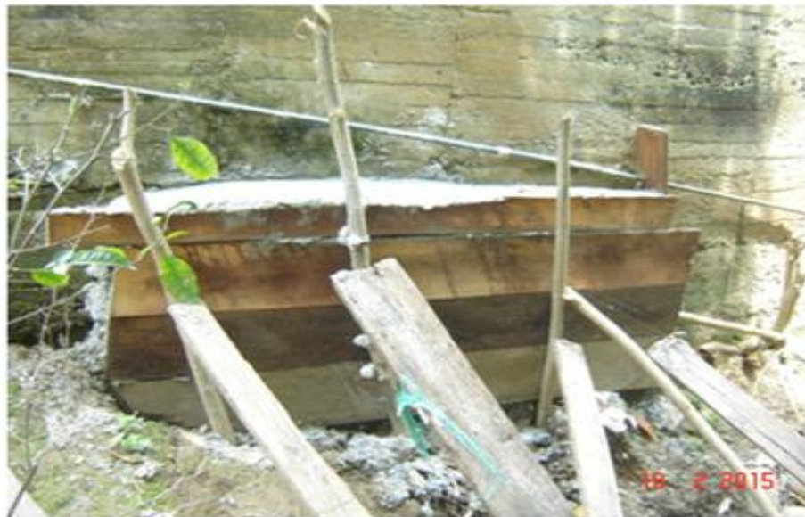
Foto Reparación Box Couvert Quebrada Hospital
