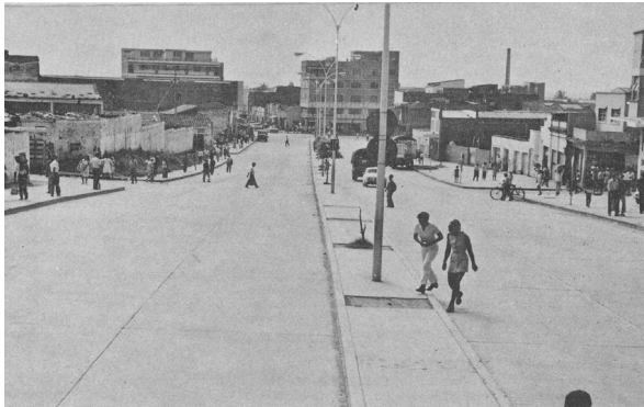
Fotografías 57 y 58 - Proceso de construcción y finalización de la avenida Eliseo Payán, en la carrera 10. a . Cali 1970-72. Memoria de dos años de labores de la Administración Holguín Sardi. Noviembre de 1972.
