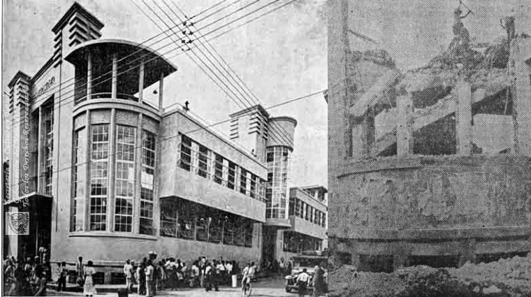
Fotografías 50 y 51 - Pabellón de Carnes de la Plaza de Mercado, 1950 . Archivo Digital Biblioteca Jorge Garcés Borrero (foto 50). Demolición Pabellón de Carnes, 1970. El País , Cali, N.º 7232. Sábado 11 de julio de 1979, p. 9 (foto 51).
