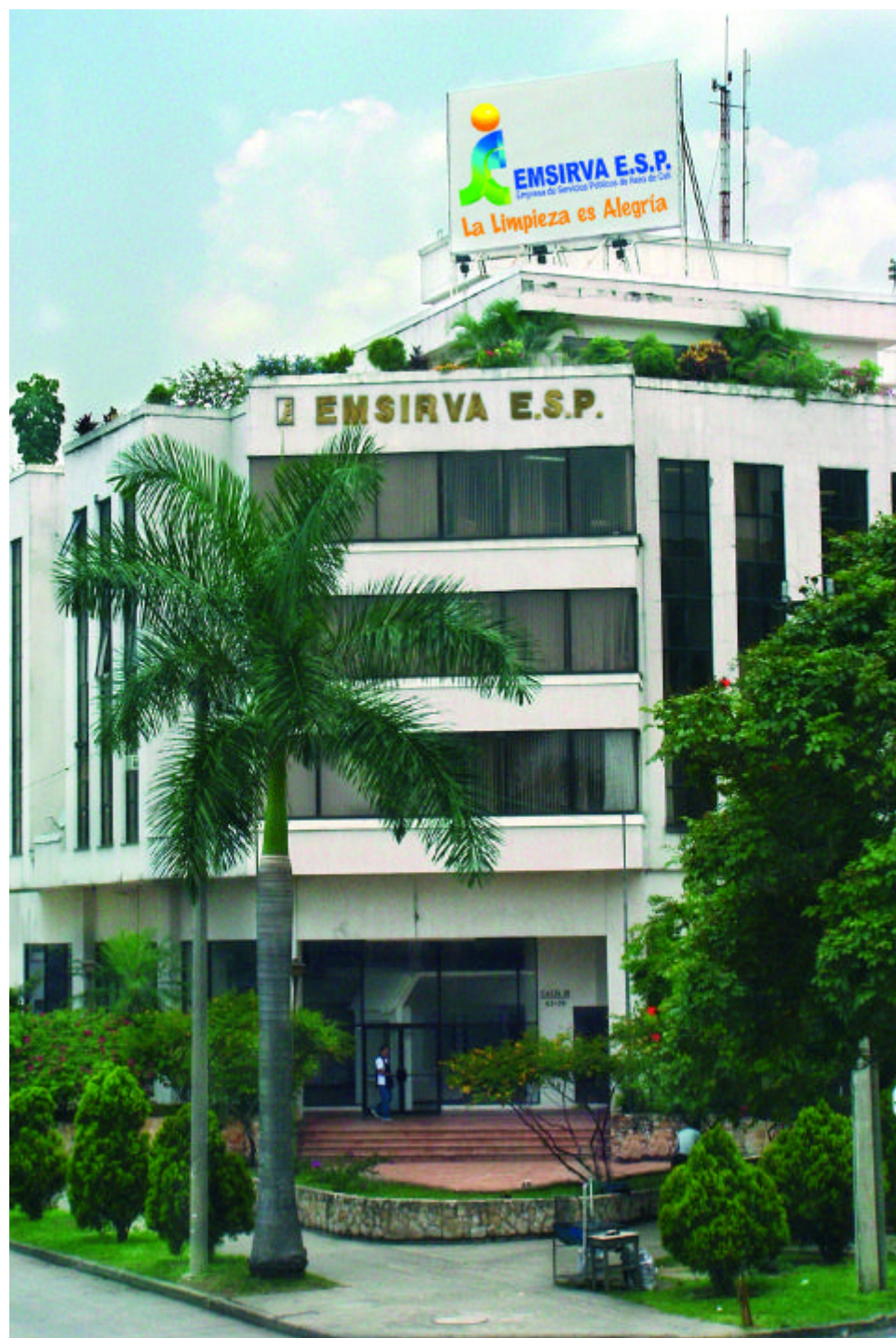
La Empresa de Servicio Público de Aseo de Cali, Emsirva E.S.P., cuenta con una sede moderna y funcional localizada sobre la Carrera 61 número 9-250, a un costado de la Autopista Sur. En ella se atienden todos los aspectos administrativos de la entidad.
