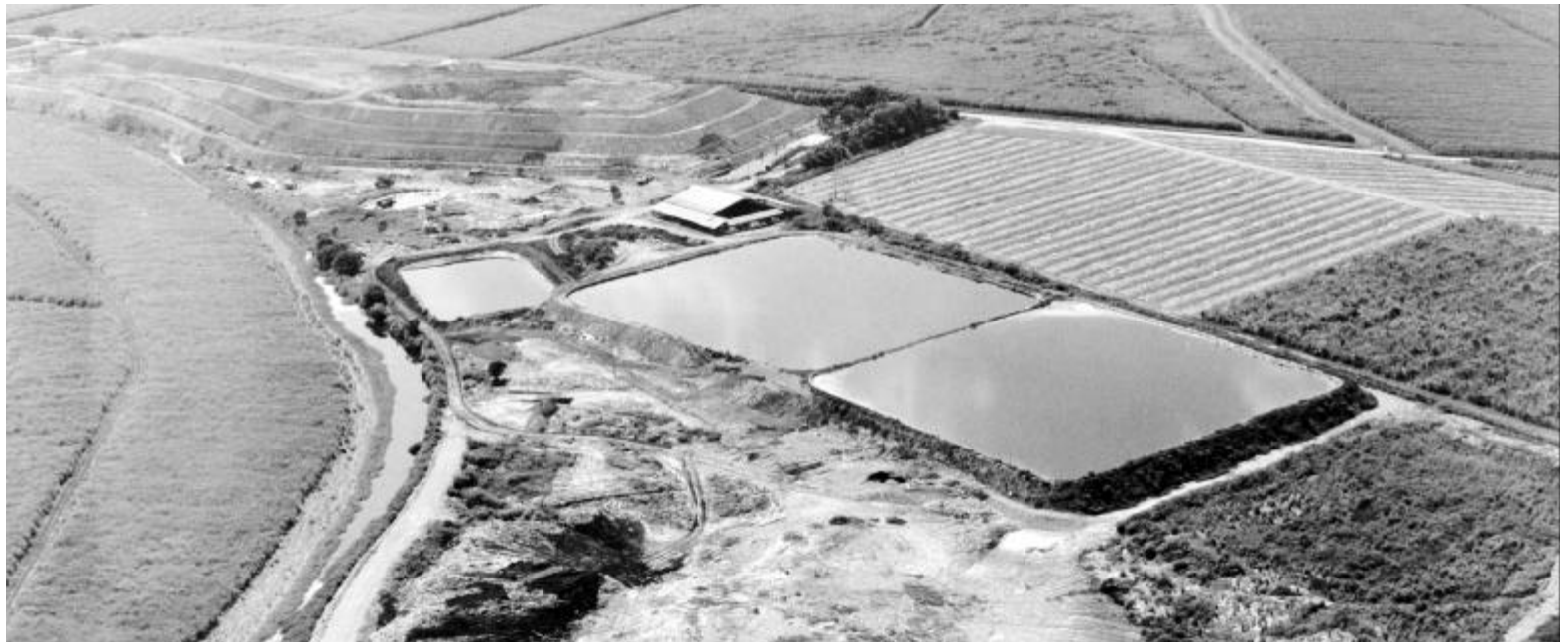
Las 1.600 toneladas de basuras que se arrojan a diario en el relleno sanitario transitorio de Navarro, producen tres litros de lixiviados por segundo. Su adecuado tratamiento es una prioridad para Emsirva.
