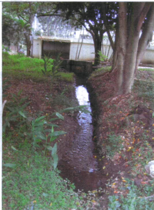
Fotografía 9. Obras existentes para control de escorrentía hacia el reservorio.
