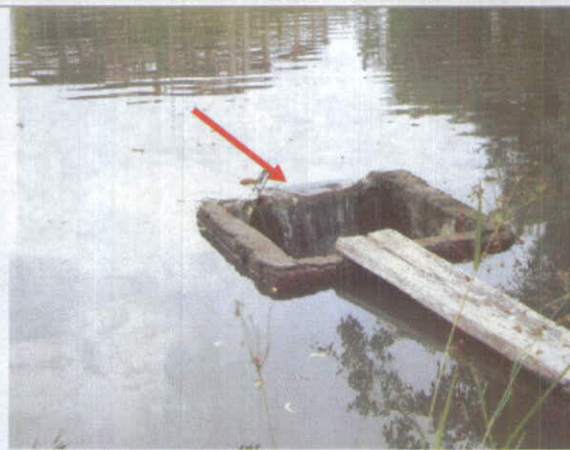
Fotografía 20. Detalle caja de desagüe, la cual aporta la sedimentación del lecho del reservorio.
