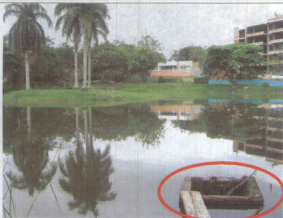
Fotografía 19. Localización de caja de desagüe construida en el reservorio.
