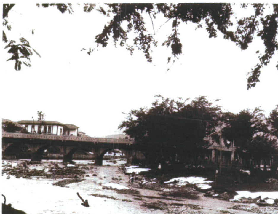
Fotografías 1-1 y 1-2 Puente Ortiz a principios del siglo XX, desde aguas arriba y aguas abajo, se observa la no existencia de muros en su margen izquierda y la amplia sección bajo el puente que cubría el cauce mayor del río
