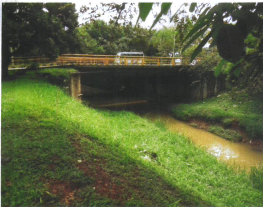
Fotografía 3-6 Vista del cauce del río -Lilí hacia aguas abajo, puente de la avenida Cañasgordas
