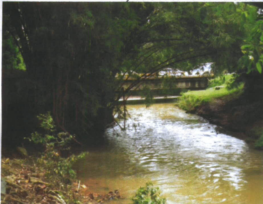
Fotografía 3-9 Vista del cauce del río -Lilí hacia aguas abajo, se observa al fondo puente de la avenida Simón Bolívar
