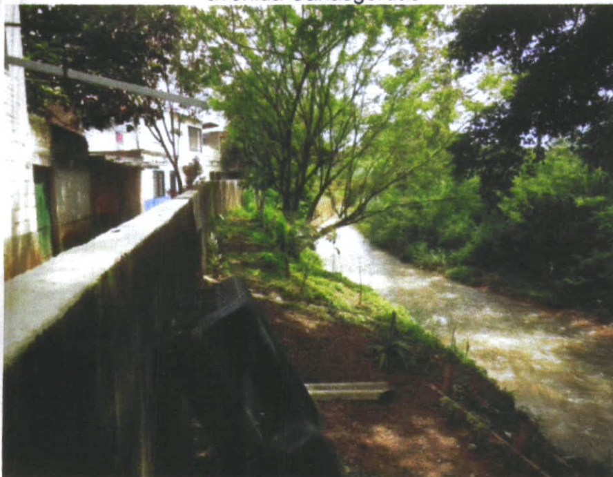
Fotografía 3-7 Vista del cauce del río -Lilí hacia aguas abajo, vivienda ubicadas sobre la carrera 102 y muro de control de inundaciones
