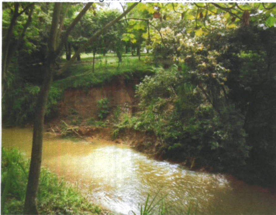
Fotografía 3-3 Vista del cauce del río -Lilí hacia aguas abajo, 150m aguas abajo de la avenida Pasoancho, erosión producida por descarga de aguas lluvias
