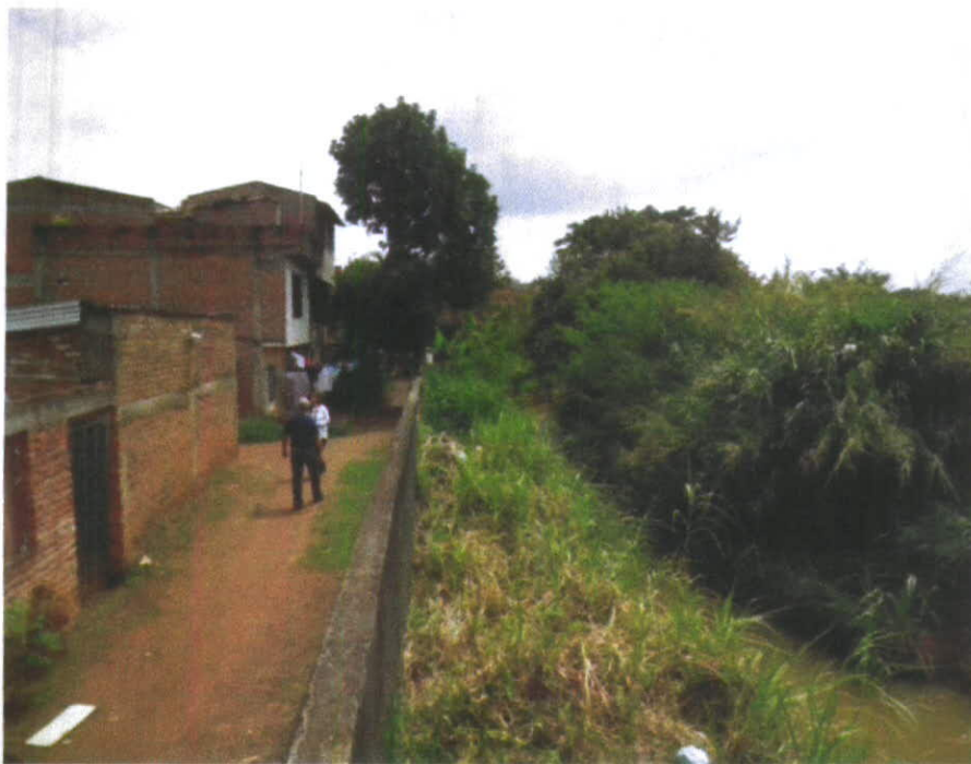
Fotografía 3-8 Vista del cauce del río -Lilí hacia aguas abajo, viviendas ubicadas sobre la carrera 102 y muro de control de inundaciones
