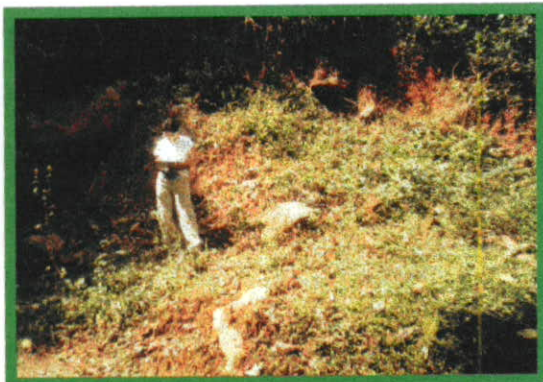
R4AF2. Inestabilidad de la banca, 100 m aguas arriba del puente de la Sirena, debido al mal manejo de las aguas de escorrentía y las aguas servidas.
