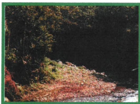
R0F1. En el sector de La Bella Suiza, se presentan fenómenos de inestabilidad del talud, debido al socavamiento de su base por efectos de la dinámica del río, la erodabilidad del terreno, la altura y la falta de protección del mismo con cobertura vegetal.
