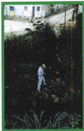
R4AF2. Inestabilidad de la banca, 100 m aguas arriba del puente de la Sirena, debido al mal manejo de las aguas de escorrentía y las aguas servidas.
