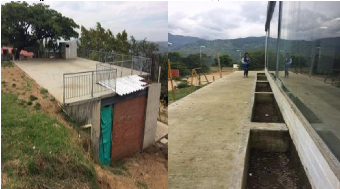
Imagen 7. Ingreso al segundo piso de la estructura y fosos de futuras plantas
