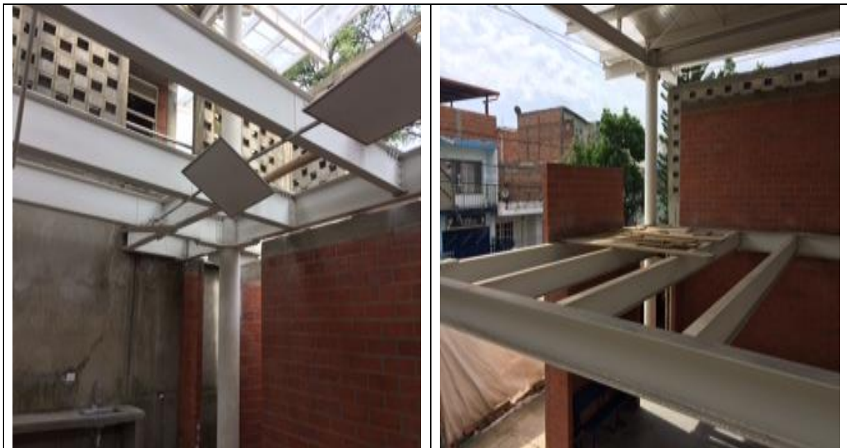
Imagen 3. Grilla de las luces LED instaladas y segundo piso sin losa
