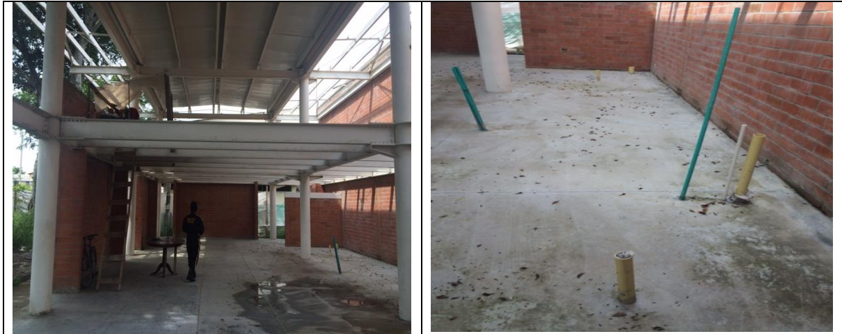
Imagen 2. Interior de la obra y pases eléctricos e Hidrosanitarios
