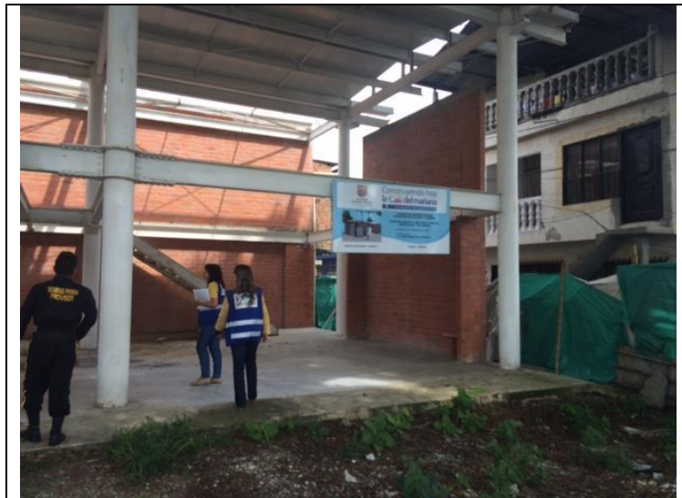
Imagen 1. Estado de la obra, fachada principal
