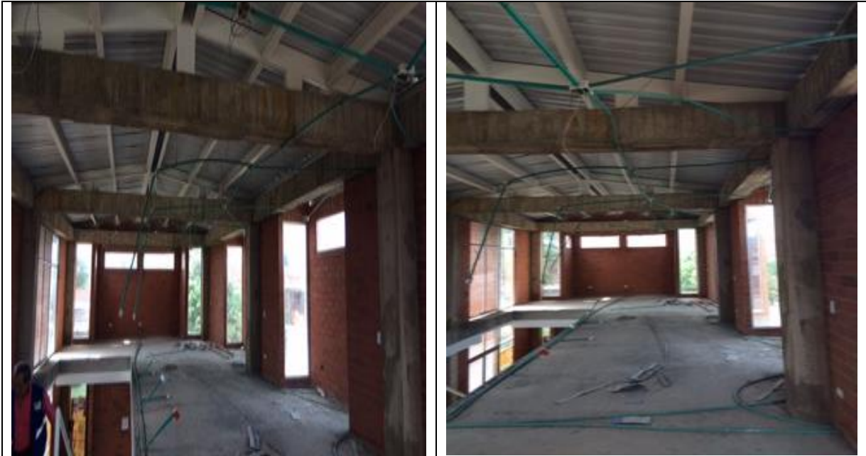
Imagen 4. Segundo piso estructura y tubería eléctrica
