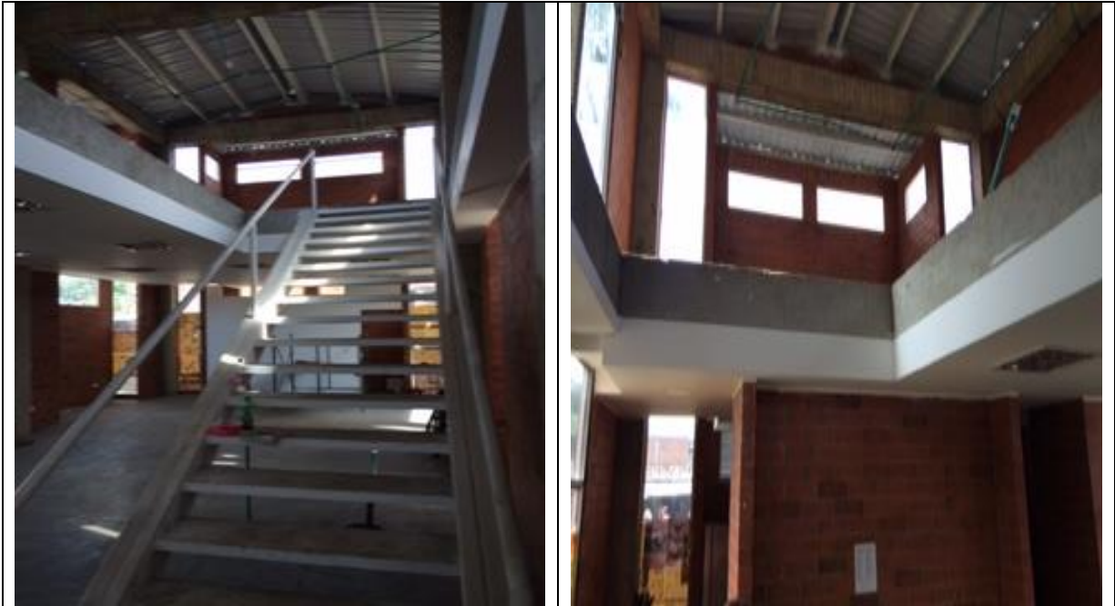
Imagen 2. Escaleras metálicas y cielo raso primer piso
