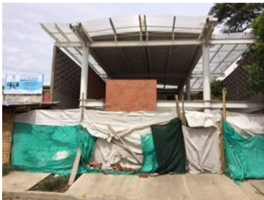
Imagen 1. Fachada principal, acceso a la obra.
