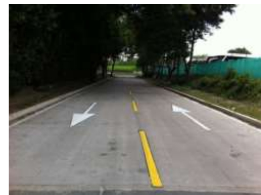
Calle 32A N entre avenidas 2A N y 3 N Fuente: Ing. Carmen Stella Gómez S.I.V
