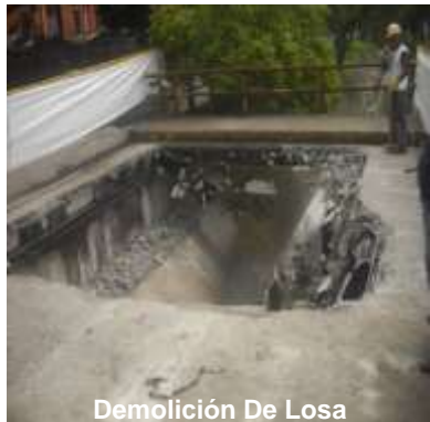
Demolición De Losa
