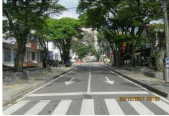
Zona Granada. Panorámica de la obra
