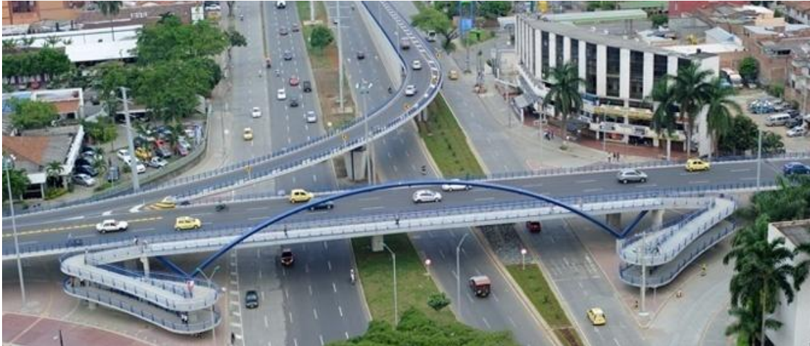
Intersección vial a desnivel Autopista Sur con Carrera 44
