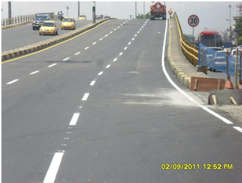
Autopista Sur Panorámica de la calzada central terminada puente de la Luna Calle 13
