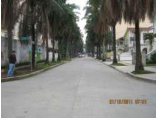
Zona Versalles Av. 5 entre Calles 22N y 23N Panorámica de la obra en funcionamiento
