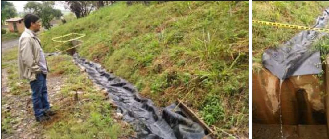
Canal perimetral en la estructura de estabilización geotécnica (gaviones tipo II) del cerro antiguo
