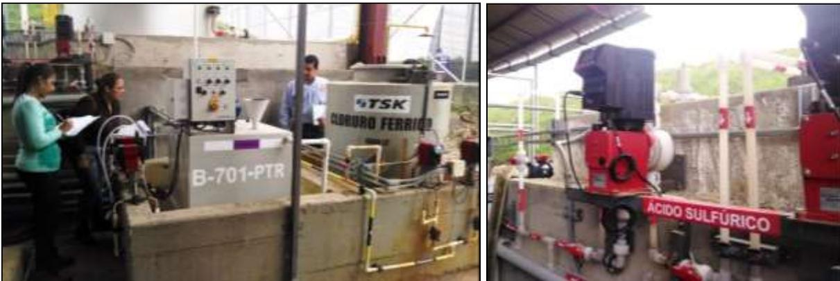
Sistema de dosificación de productos químicos (reductor de pH, coagulante y floculante) en la etapa de pretratamiento y bombas de dosificación
