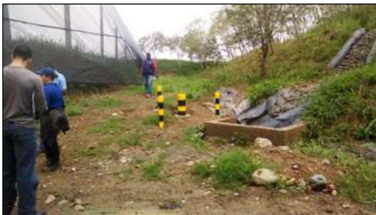
Construcción de pozo de monitoreo de aguas subterráneas entre una de las patas del vaso 7 y la laguna N° 4
