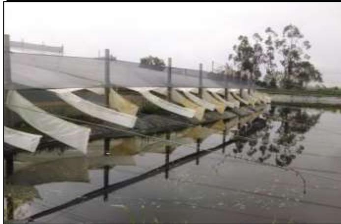
Sistema de drenaje de aguas lluvias de la laguna de evaporación forzada hacia la laguna N° 6
