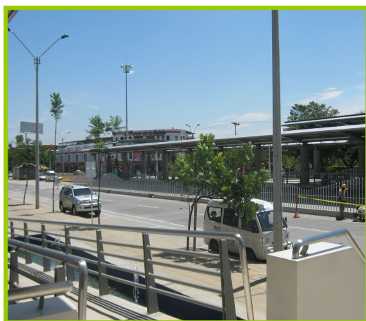
Vista Estación de Parada
