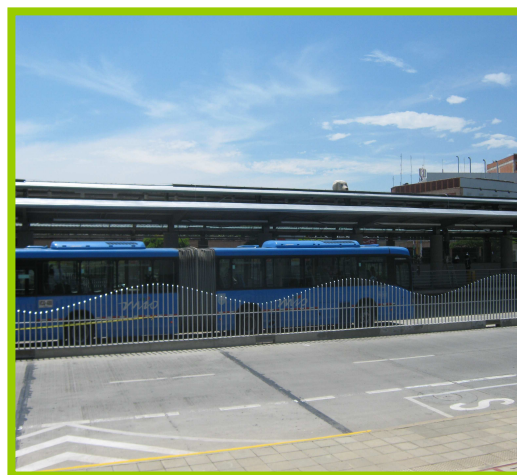
Encerramiento Estación de Parada
