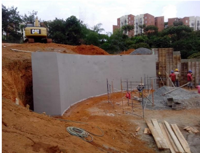
Muro de Contención Administración
