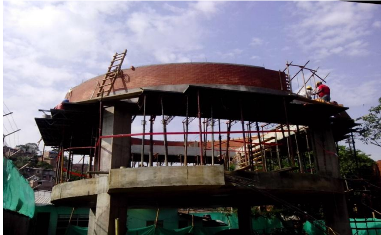
Instalación de Mampostería en Bloque estructural.
