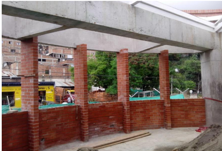
Segundo Nivel Mampostería en Bloque estructural.
