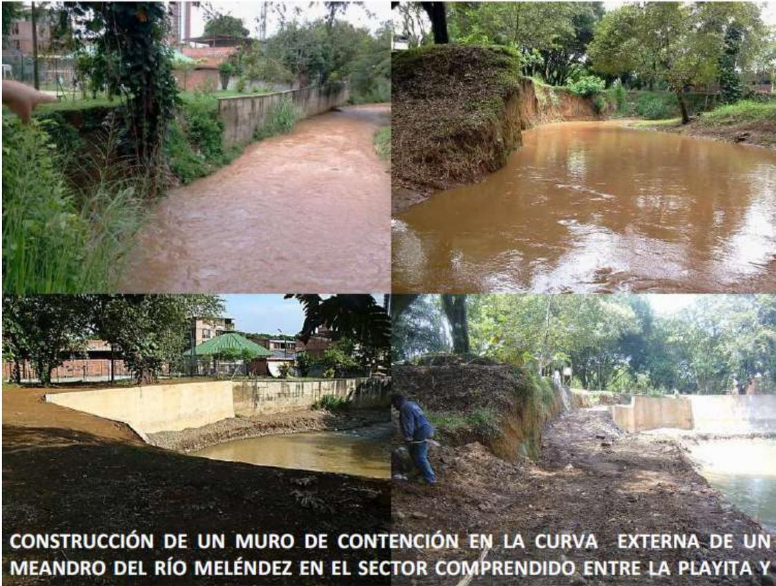
**CONSTRUCCIÓN DE UN MURO DE CONTENCIÓN EN LA CURVA EXTERNA DE UN MEANDRO DEL RÍO MELÉNDEZ EN EL SECTOR COMPRENDIDO ENTRE LA PLAYITA Y**
