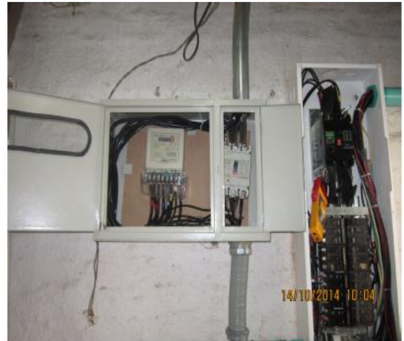
4. CAJA NUEVA CON EL MEDIDOR DE ENERGÍA ACTIVA Y TABLERO TIFÁSICO DE 24 CIRCUITOS CON LAS RESPECTIVAS PROTECCIONES DE LOS CIRCUITOS DE DISTRIBUCIÓN
