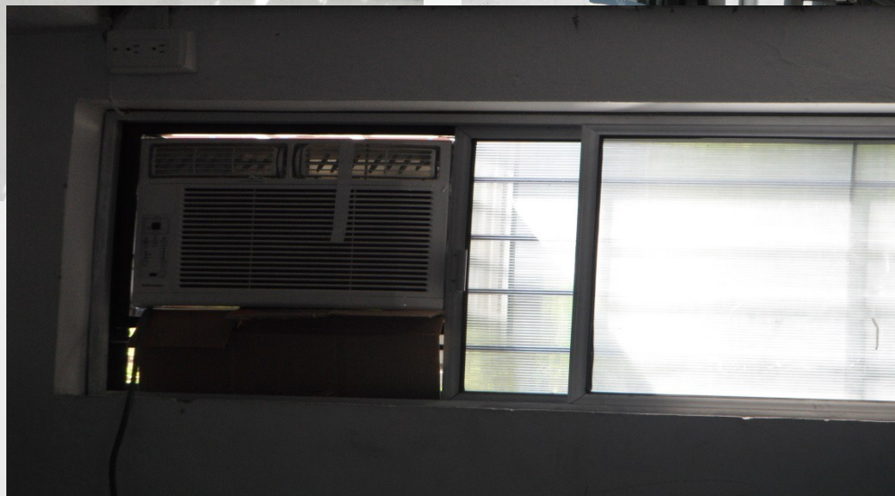
INSTALACION AIRES ACONDICIONADOS
