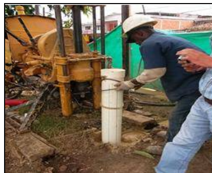
Entubado del Piezómetro
