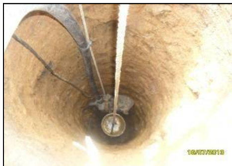
Perforación del Piezómetro
