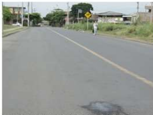
Foto del fresado ejecutados en la Calle 123 entre Kr 25 y Kr 261 Fuente: Metrocali S.A. Dirección de Construcciones. Agosto - 2014.
