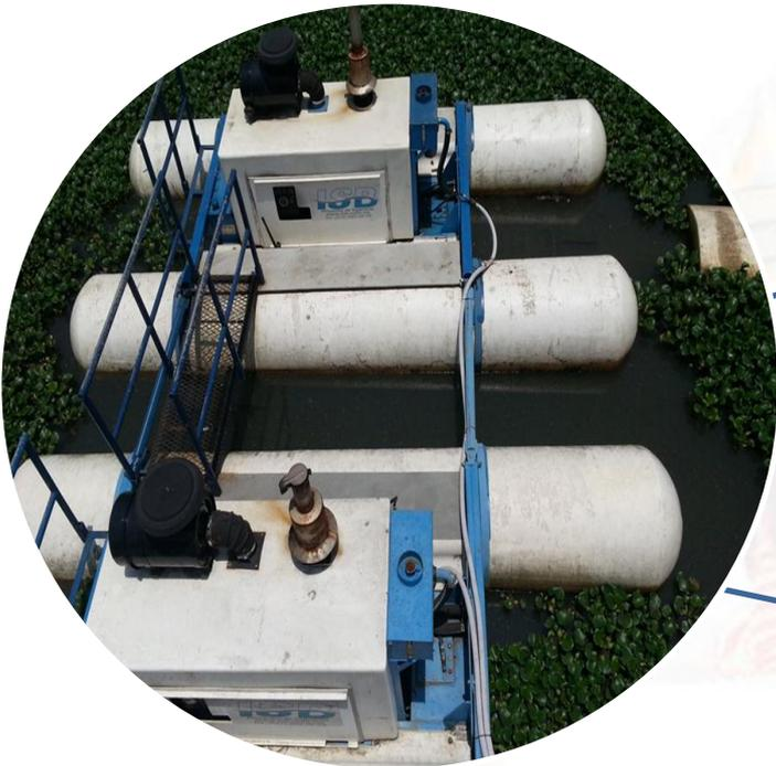
Se aumenta la capacidad instalada de 32,84 m<sup>3</sup>/seg a 37,98 m<sup>3</sup>/seg logrando bajar los niveles del Canal Oriental en un día después de un evento de lluvia fuerte en el área de influencia del canal oriental.
