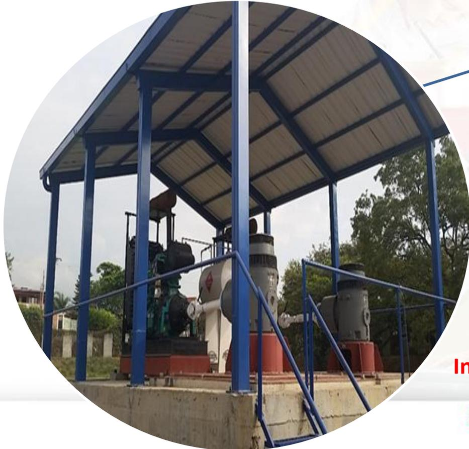
Se aumenta la capacidad de bombeo de aguas lluvias de 8 m<sup>3</sup>/seg a 13,5 m<sup>3</sup>/seg.
